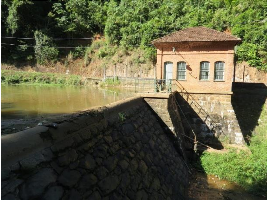
Figura 8: Usina da Serra
